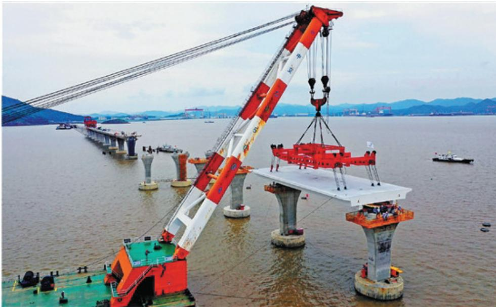
日前,施工人员在舟岱大桥海上互通段架设重达288.9吨的钢箱梁。舟岱大桥是宁波舟山港主通道工程主线的重要一环,全长27.9公里,计划2021年建成通车。
