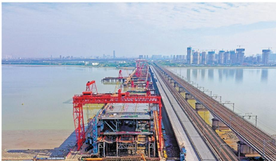
10月25日,杭州钱塘江新建大桥开始首轮钢桁梁顶推。钱塘江新建大桥是沪杭甬高速公路杭州市区段改建工程的关键性工程,大桥全长1350.8米,上层为8车道高架快速路,下层为双线快轨。
