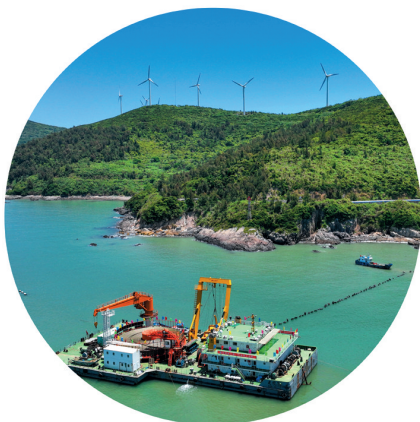
▲全国首条35千伏低频海底电缆在大陈岛入海 葛嘉仪 摄
