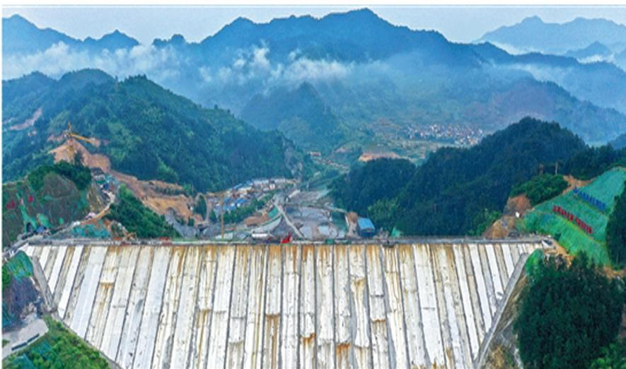
5月20日,衢州市开化水库大坝防渗面板全面浇筑完成,意味着水库已经具备蓄水条件。开化水库工程地处钱塘江源头,是国家重点推进的150项重大水利工程之一,建成后将为钱塘江流域筑起一道坚固的防洪安全屏障,为下游衢州相关区县提供重要战略水源保障。
